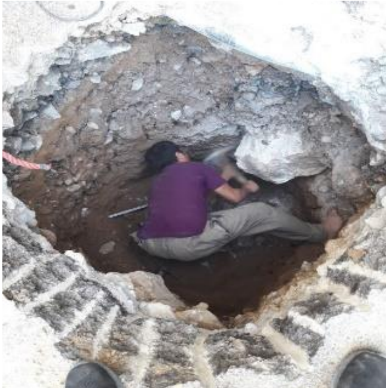
حفر چاه در سطح منطقه
