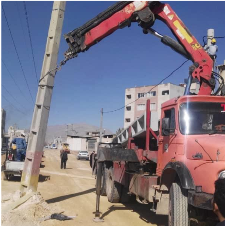
جابجایی شبکه برق بلوار صلح
