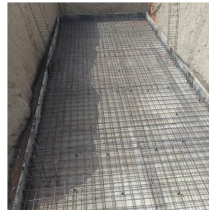
احداث حوضچه دفنی بتنی
