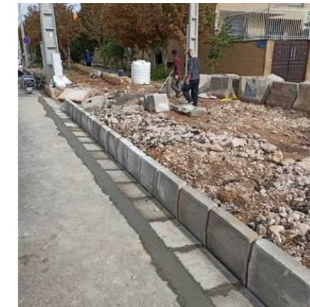
تعمیر تک لبه های سطح منطقه
