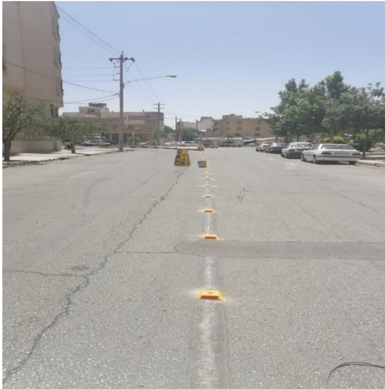
اجرای تفکیک مسیر با گلمیخ مکعبی در خیابان ایثارگران
