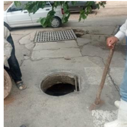
ایمن سازی و نصب منهول
