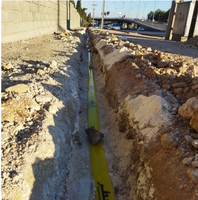
لوله گذاری اب المان پل گچی
