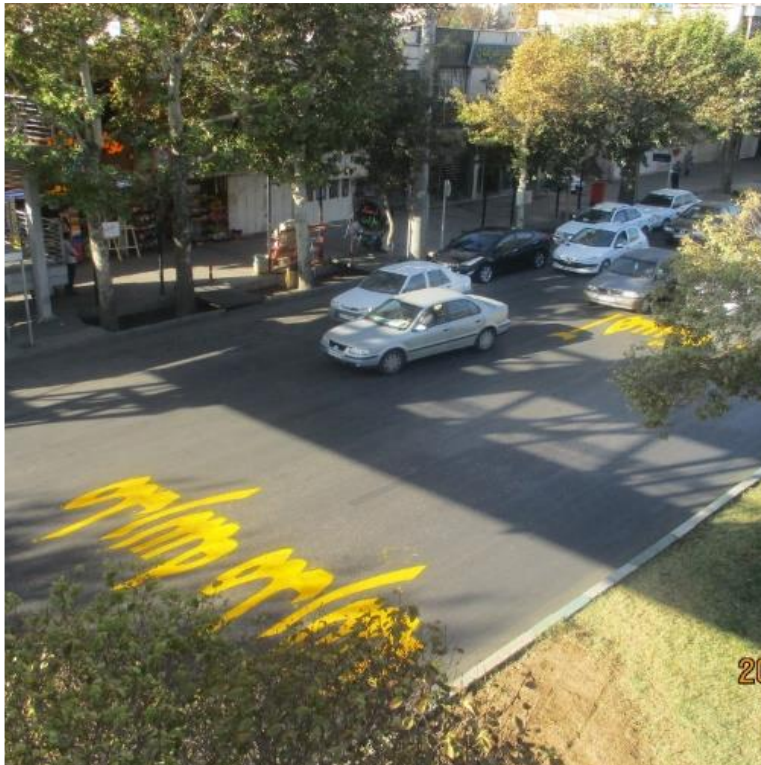
تیپ ایمن سازی مدارس با اجرای شابلن کف
