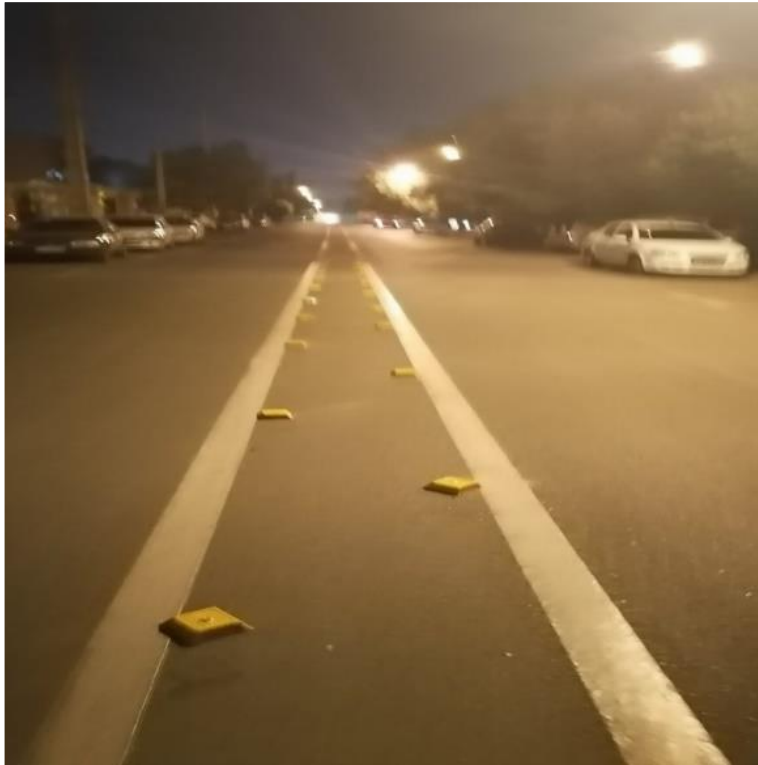
تفکیک مسیر با نصب گل میخ مکعبی در خیابان علیزاده
