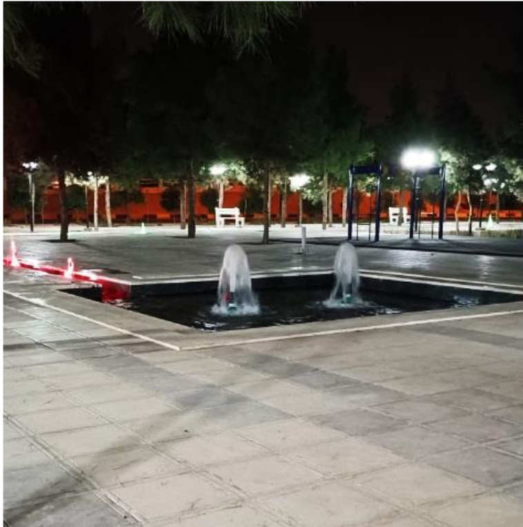
اجرای تاسیسات مکانیکی ابنمای پارک پرستو
