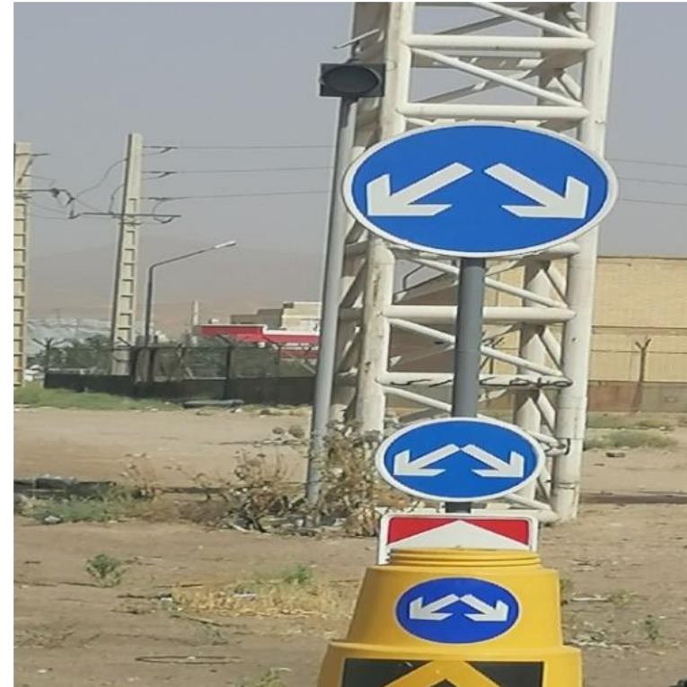
نصب تابلو و علائم و تجهیزات ورود خروج به کمربندی
