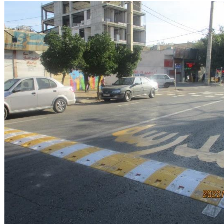
تیپ ایمن سازی مدارس با اجرای سرعتگیر و خط ایست
