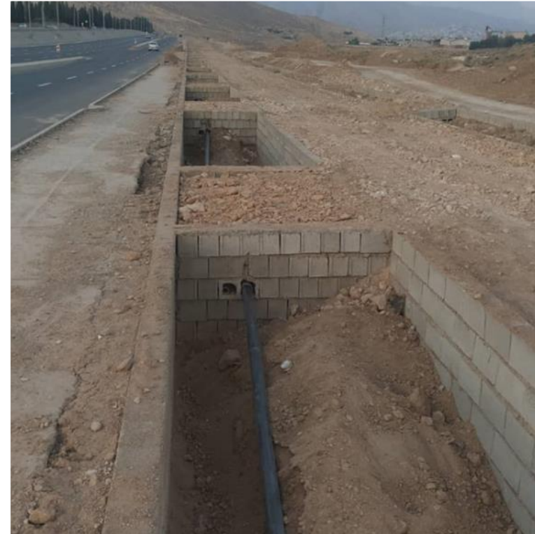
اجرای آبرسانی بلوار مهندسین
